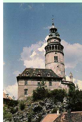
před opravou v roce 1993
