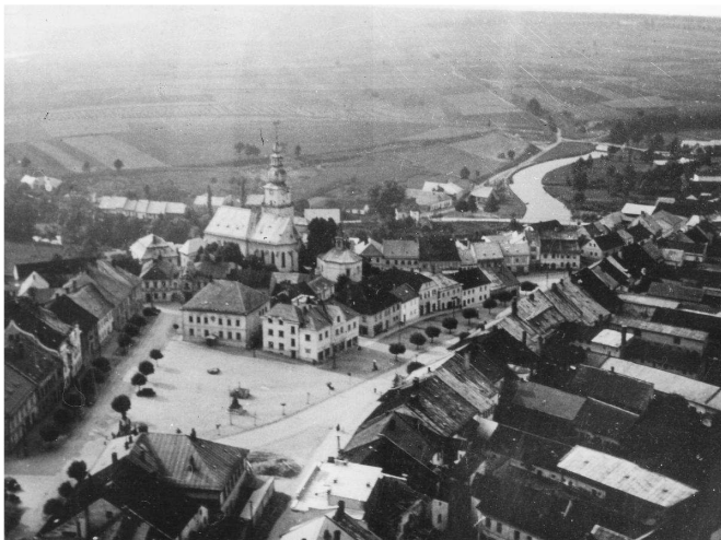
Příloha č. 16: Letecký pohled severozápadním směrem na Město Žďár v r. 1925
