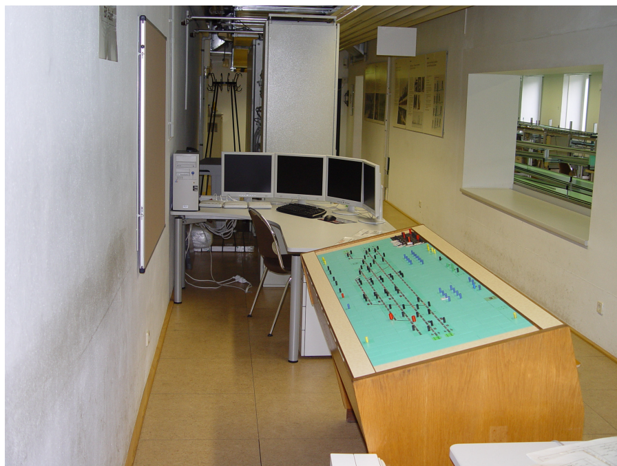
11-6: Technická univerzita Drážďany, pult a reléová skříň reléového zabezpečovacího zařízení (foto autor)
