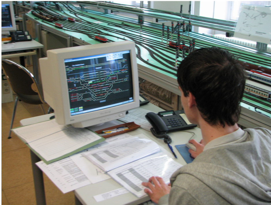
11-7: Technická univerzita Drážďany, zadávací pracoviště elektronického zabezpečovacího zařízení (foto autor)
