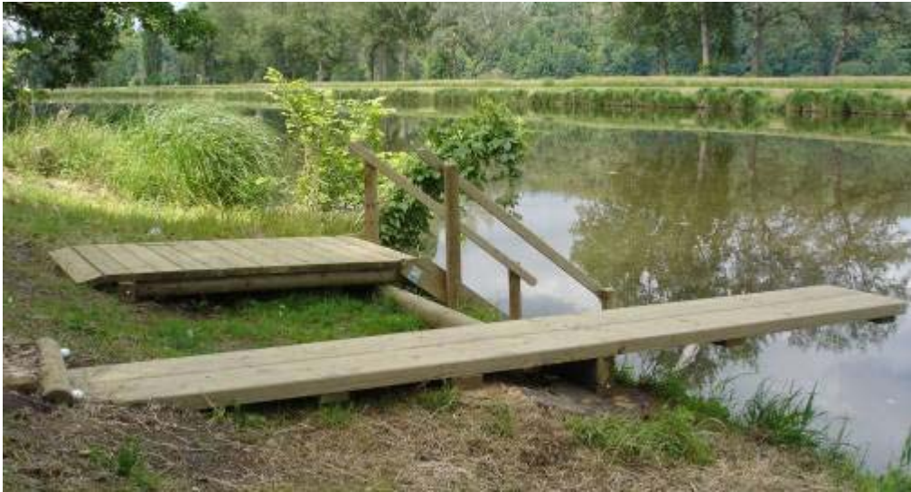
2006 schody do vody vč. skokánku 1
