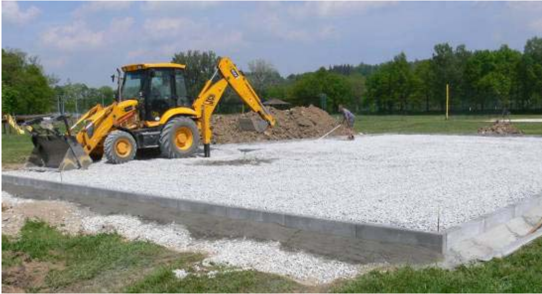
2007 výstavba basketbalového hřiště 1
