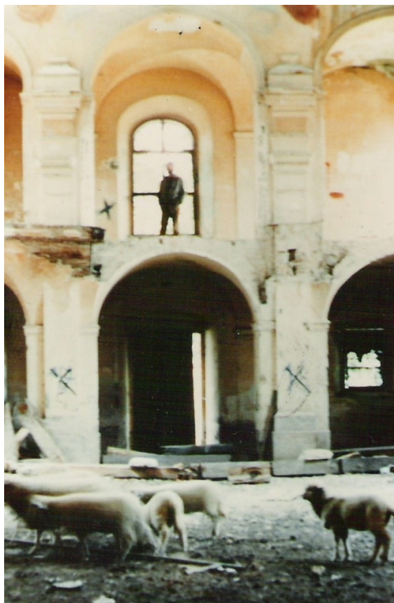
Interiér kostela po roce 1989
