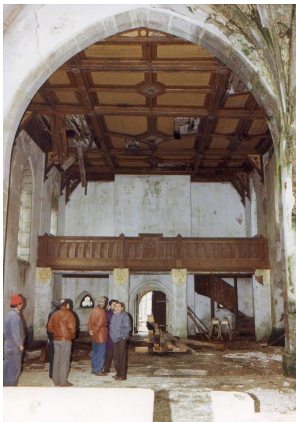
Interiér kostela před opravami
