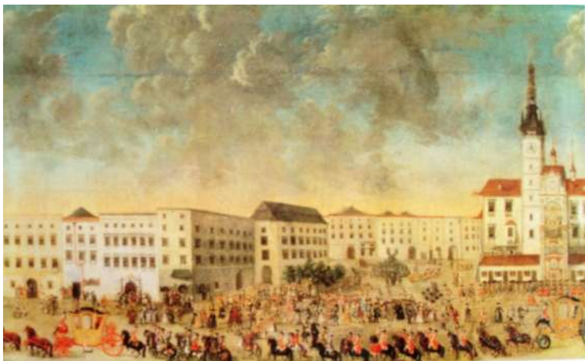
obr. 66 Detail C- Roh Horního náměstí- nárožní domy ulice Ostružnické a vpravo radnice
