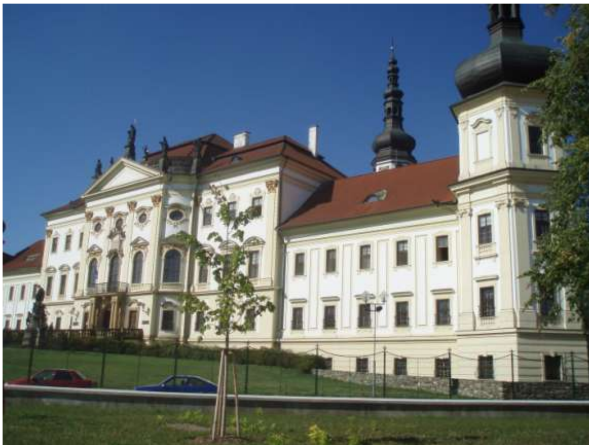
obr. 52 (Průčelí kláštera Hradisko a nárožní věž. Foto: Mikulková, rok 2008)
