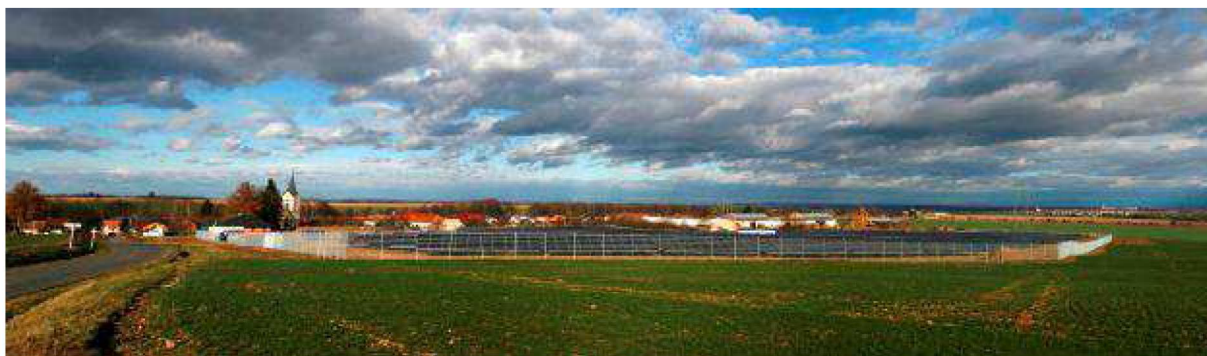
Obr. č. 8 Fotovoltaická elektrárna Morašice, instalovaný výkon 1 065 kWp, převzato z
