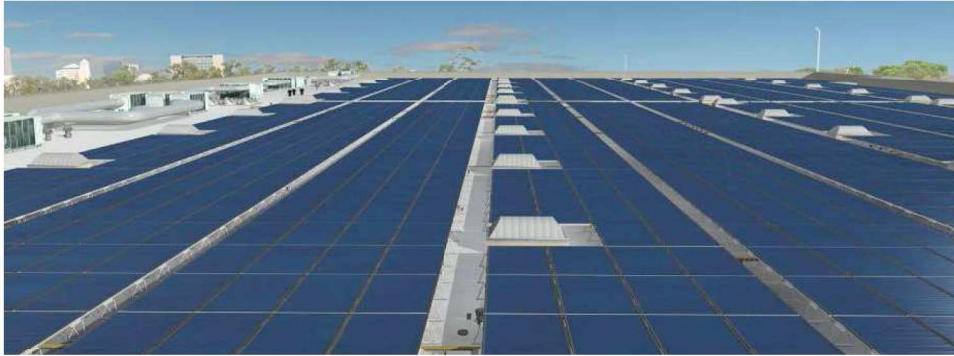
Obr. č. 7 Amorfnní články – příklad realizace, převzato z [13]
