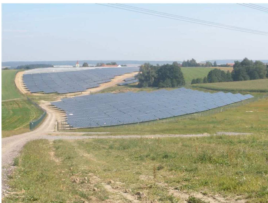
Obr. č. 10 Fotovoltaická elektrárna Bohuňovice, instalovaný výkon 3 011 kWp, převzato z [16]
