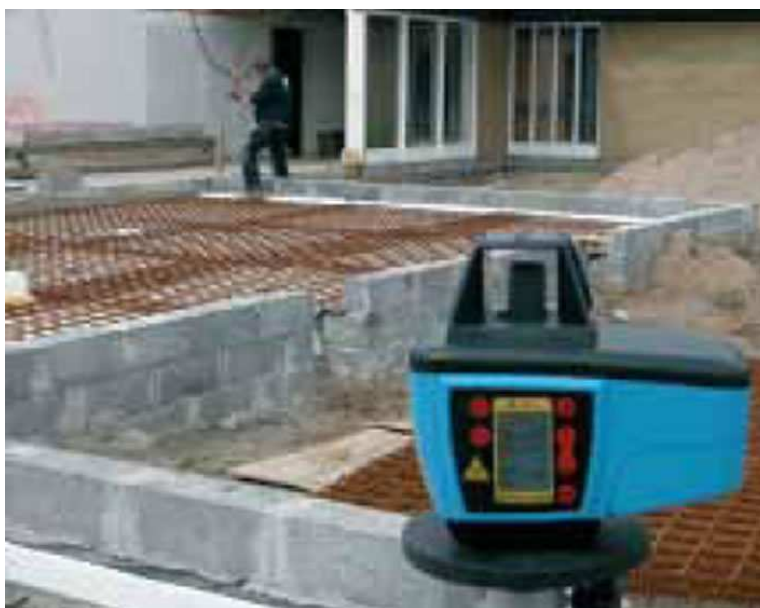
Obr. č. 7 Rotační laser používaný při betonáži ( http://www.geopen.cz/files/uziti_laseru.pdf )
