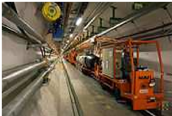
Obr. 7.5: Jeden z více než 1800 supravodivých magnetů urychlovače LHC na transportním vozíku uvnitř 27 km dlouhého podzemního tunelu. [2]
