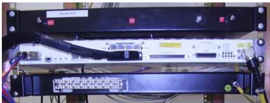
Obr. 20 – Umístění zdroje, IDU, Krone pásky v objektu Femat Praha
