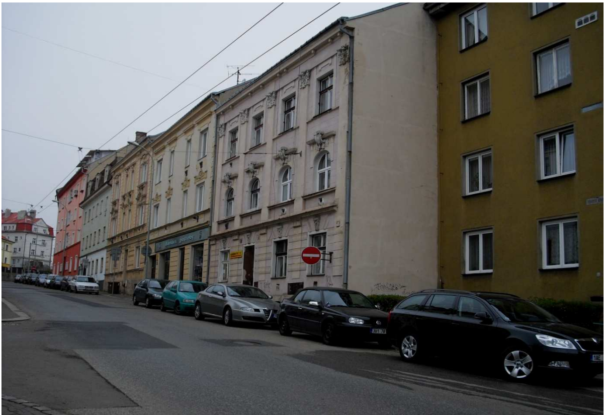
Foto 9. Vícepodlažní ulicově-bloková zástavba v centru města (JB)
