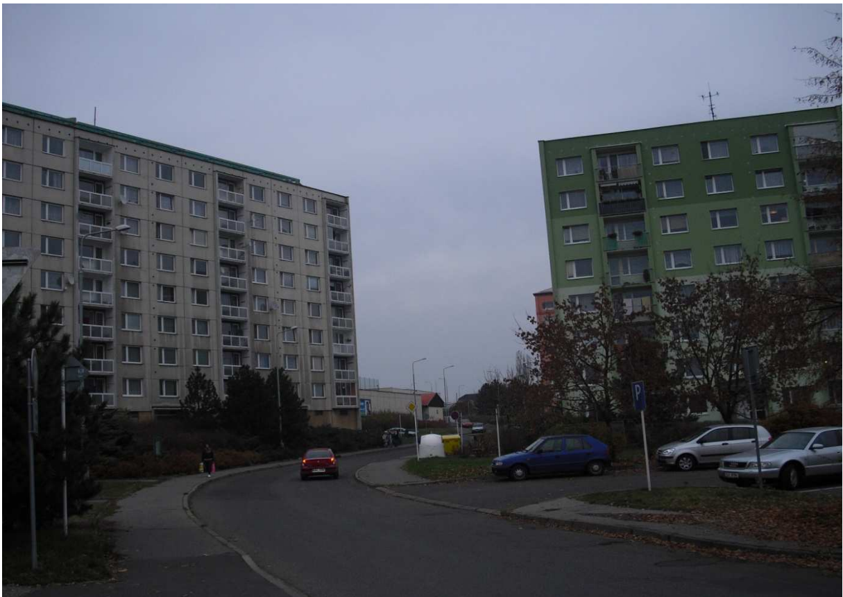
Foto 13. Zástavba rodinných domů v městské části Sebzuzín (JB)
