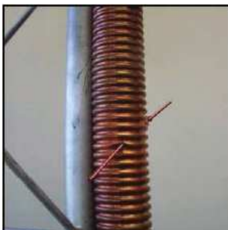
Obrázek č.3 - Poškození kabelového vedení
