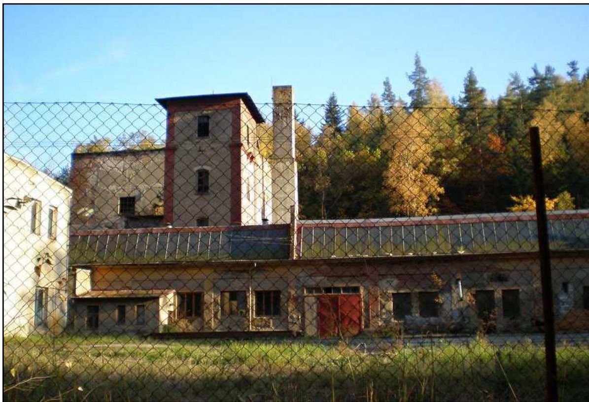
foto č. 10: Pohled na část bývalého továrního komplexu v Josefově Huti. (foto: autorka, říjen 2008)
