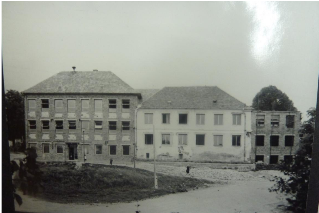
Obr. 4. Druhá etapa přístavby školy.
