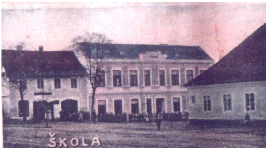
Obr. 2 Budova staré školy, tzv. Buchárna
