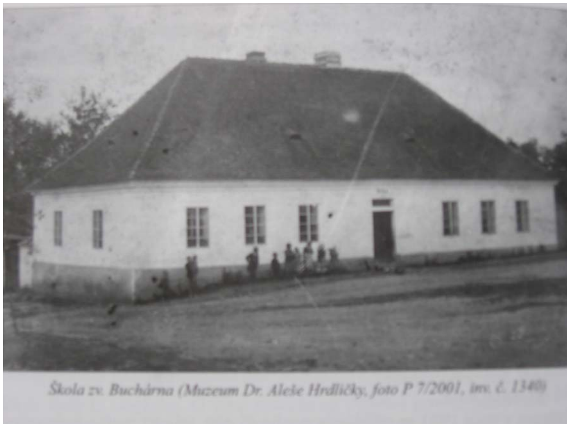
Obr. 1 Budova staré školy, tzv. Buchárna
