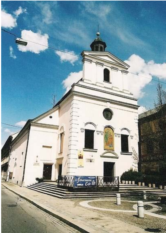
Obrázek 3: Bývalý kostel svaté Anny, který od roku 1988 slouží jako hudební síň Otakara Jeremiáše.
