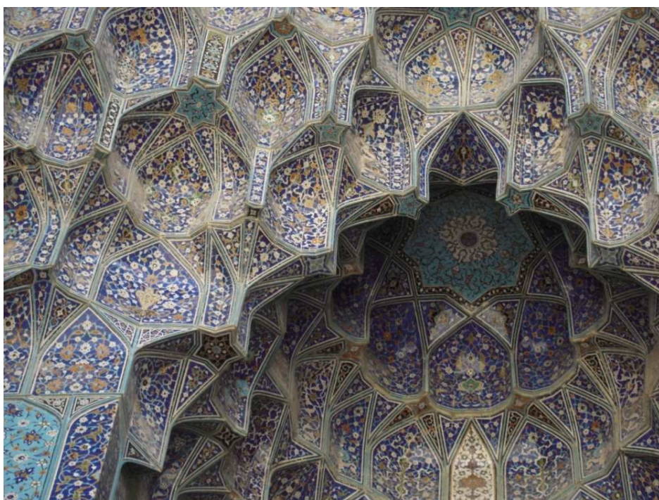
Obr. 1.4.p: detail horní části vstupního portálu kupole mešity Immáma Chomejního v Esfahánu
