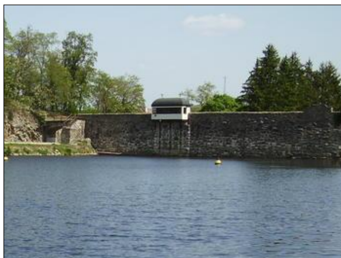
Obr. 6 Jevišovická údolní nádrž
