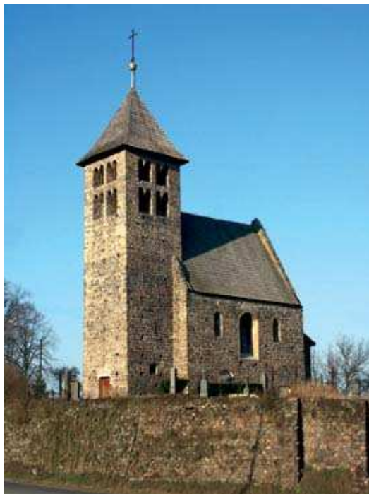
Kostel sv. Petra a Pavla, Poříčí nad Sázavou
