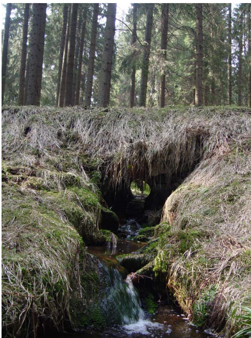
Obr. 38. Peřej (35cm) a betonová roura, spojující dvě části potoka. Foto T. Ditrich.
