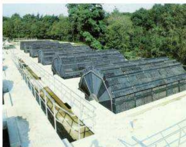
Obr. 14: Rotační bioreaktor (Malá, 2005)
