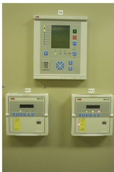
Obrázek 11 - Pole 2BA0GA3 po záměně čelní pohled. Nahoře terminál vývodového pole, dole napět'ové ochrany
