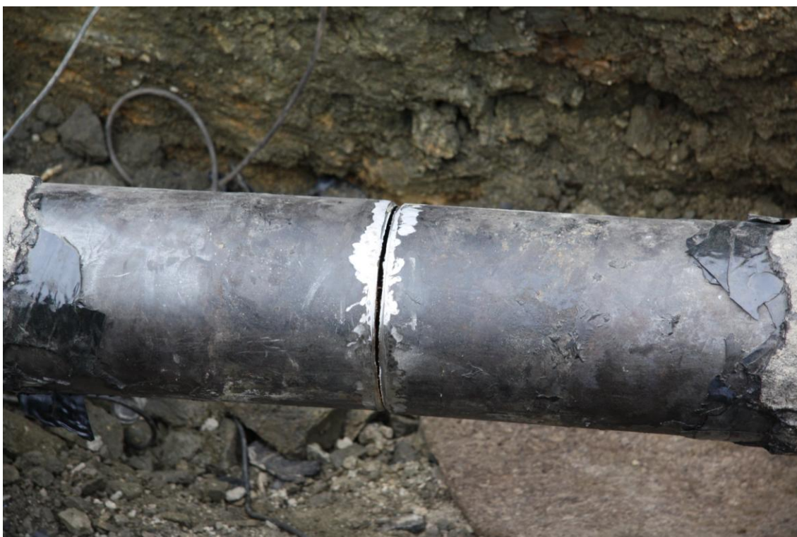
Obrázek 8 - Připravené potrubí na svařování
