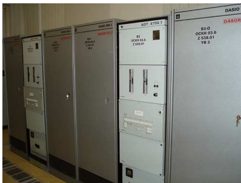
Foto. 2.1 Rozmístění skříní zdvojeného systému DASOR 601JR, propojeného přes MPS, skutečné provedení.
