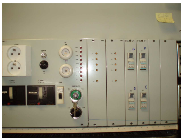
Foto. 3.2.1 Napájecí zdroje K927 Z.
