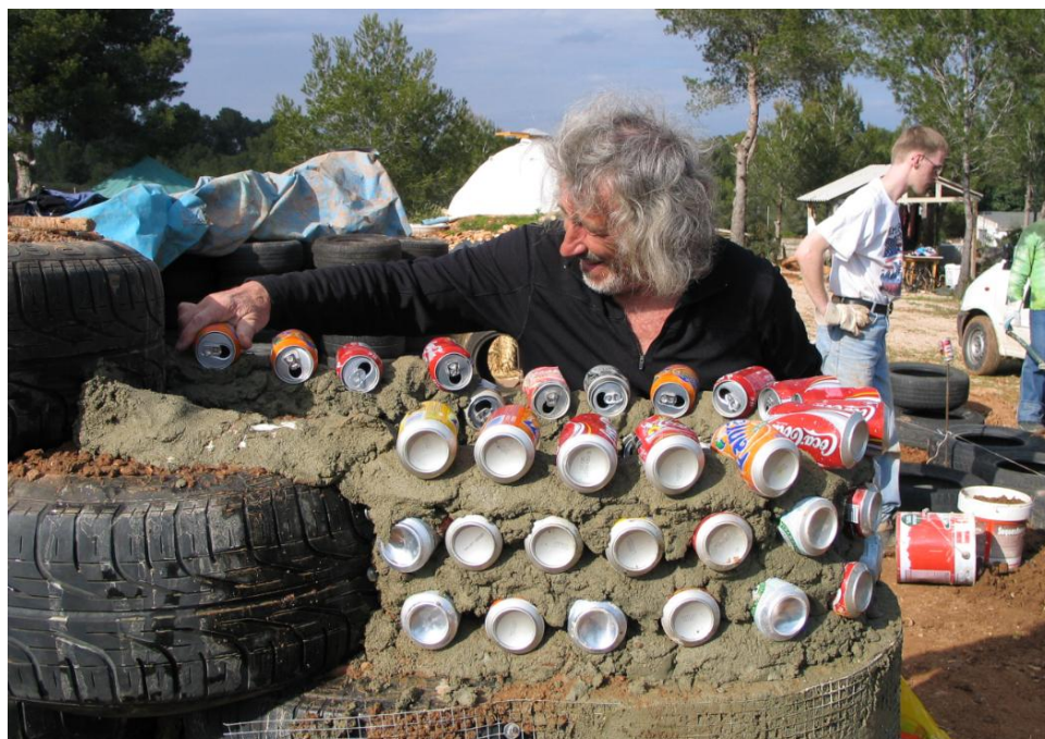
Obr. č. 48: Michael Reynolds – architekt odpadu – při práci v Novém Mexiku
