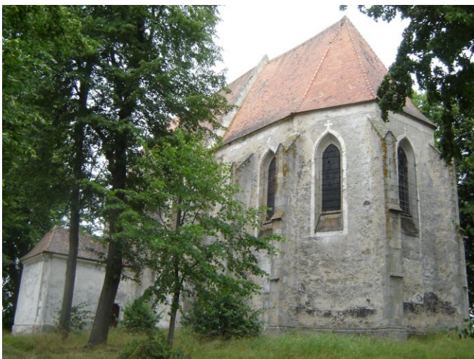
Foto 34. Poutní kostel Božího Těla
