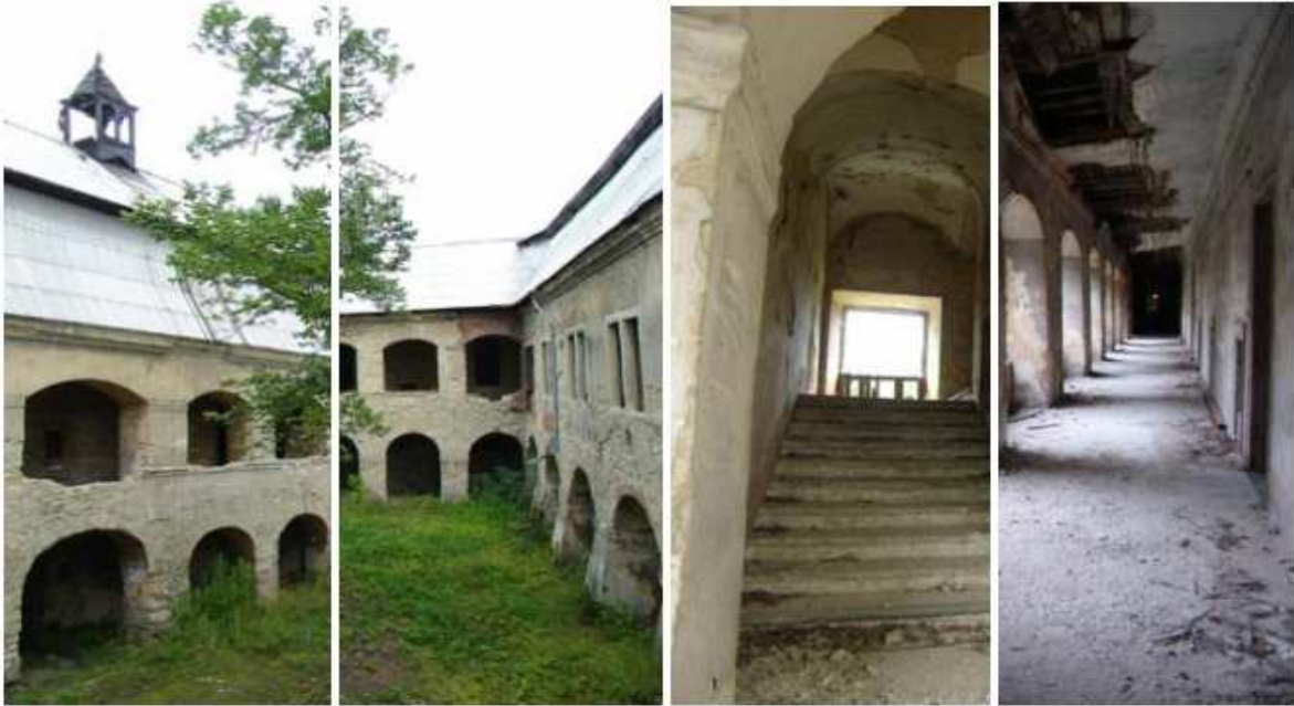
4.3. Současný stav byšického zámku: vnitřní arkádové nádvoří a zničené interiéry zámku [fotoarchiv autora]
