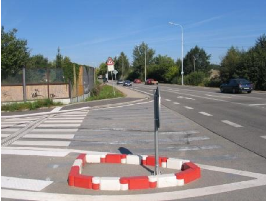
Obrázek č.7 – Přechod pro chodce – Denisova ulice, Jindřichův Hradec 61
