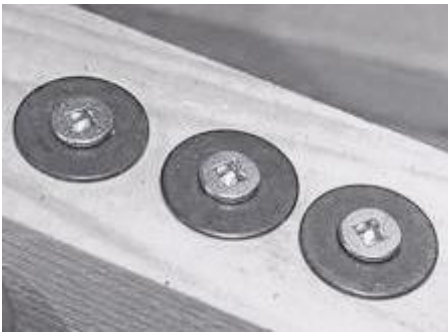
Obr. 17 Použití podložek u vrutů do dřeva
