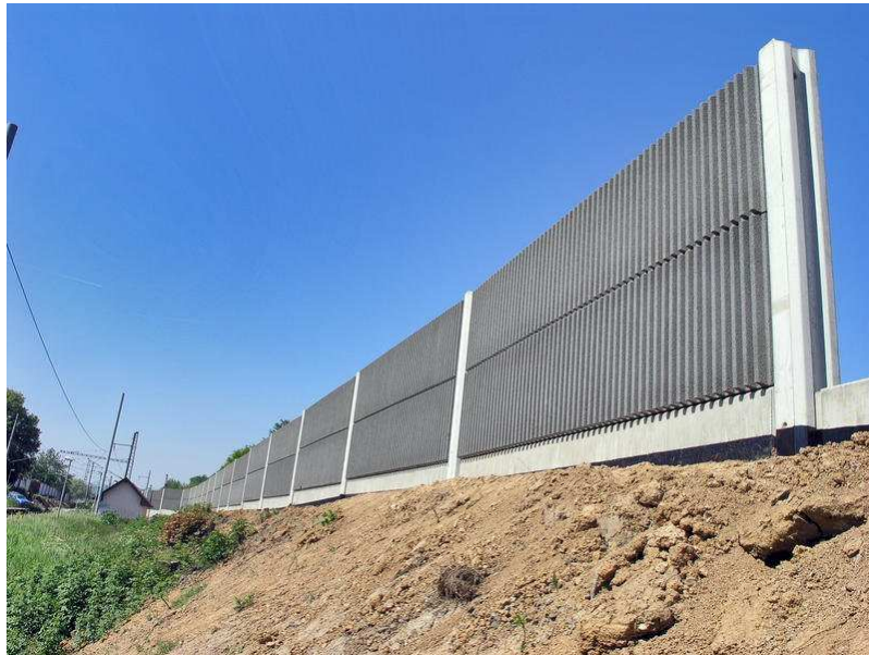
Obr. 10 – Absorpční stěna s povrchem z pórobetonu [14]
