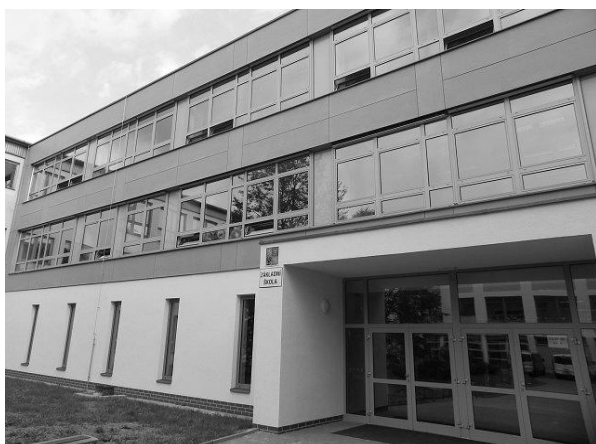
Obr. č. 2: Nová budova ZŠ Hradecká Telč
