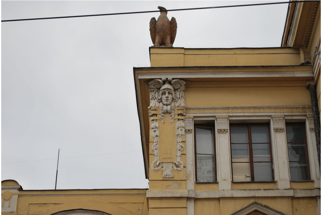
Obr. 19 Detail secesního nádraží v Českých Budějovicích
