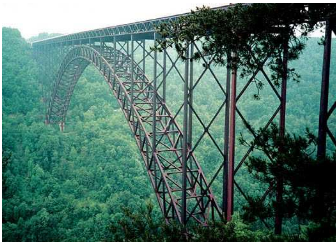
Obrázek 76 - Most přes New River [16]
