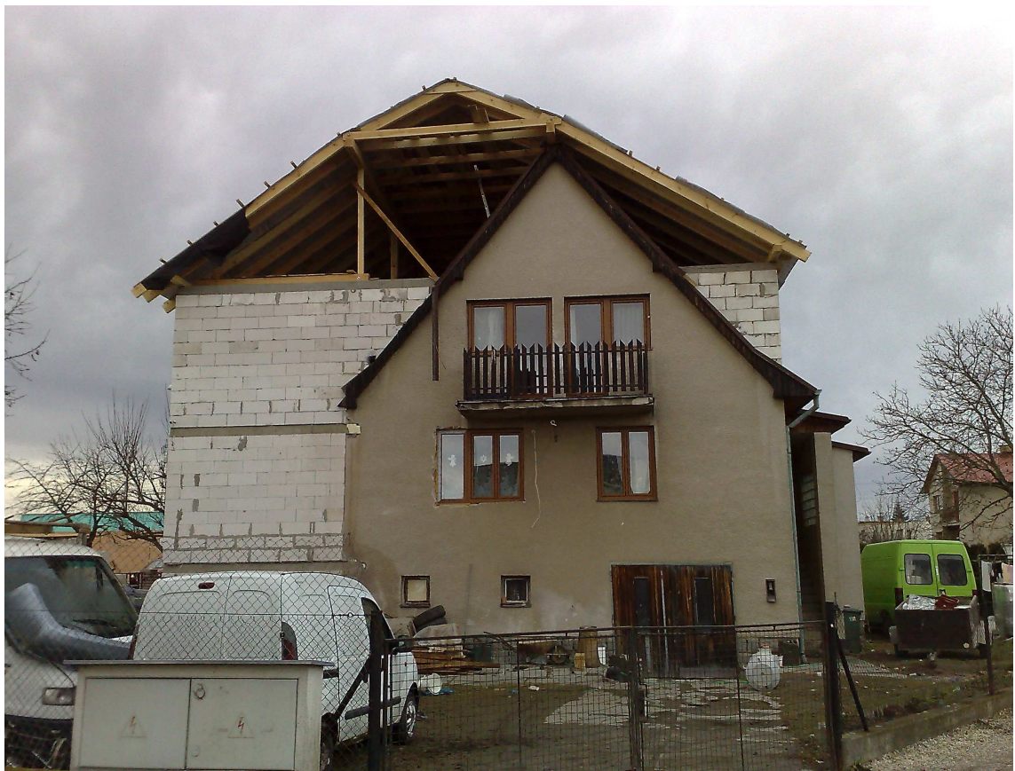
Foto 10: Přestavba rodinného domu (zdroj: autor)
