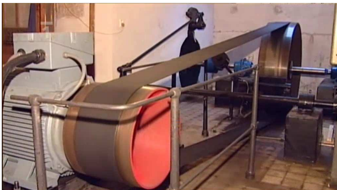
Obr. 5.18 – Křížíkova elektrárna zámeckém mlýnu v Jindřichově Hradci [23]
