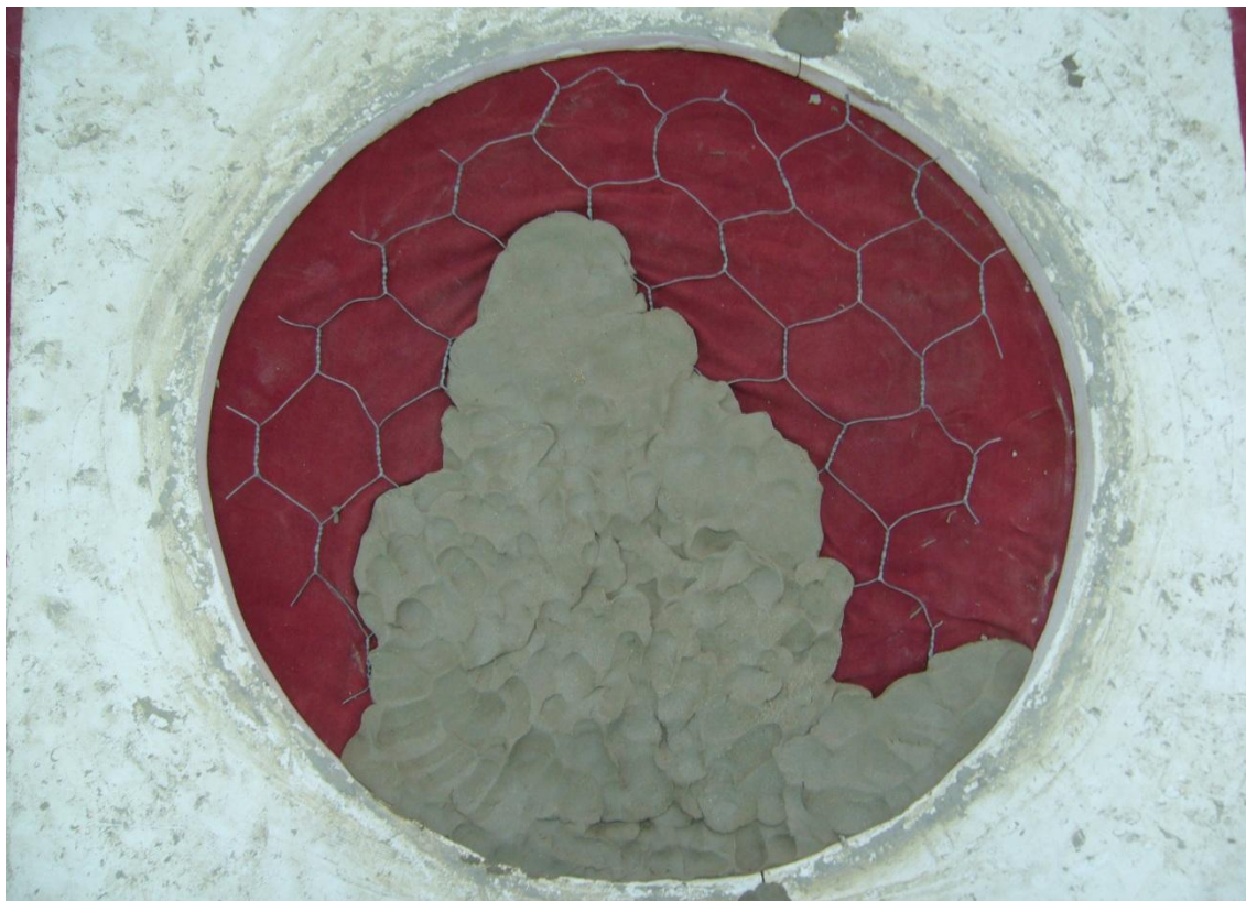
Obr. č. 3: Vrstvení hlíny do formy
