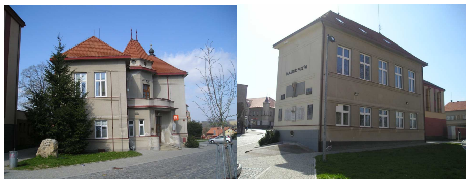
Obrázek č. 11 Původní budova MěDDM Vlašim
