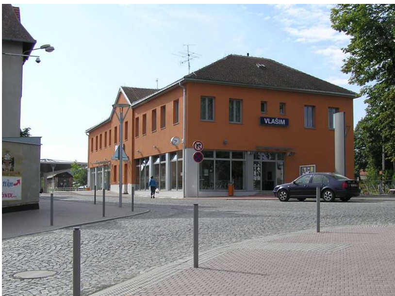
Obrázek č. 6 Nynější pohled na budovu nádraží
