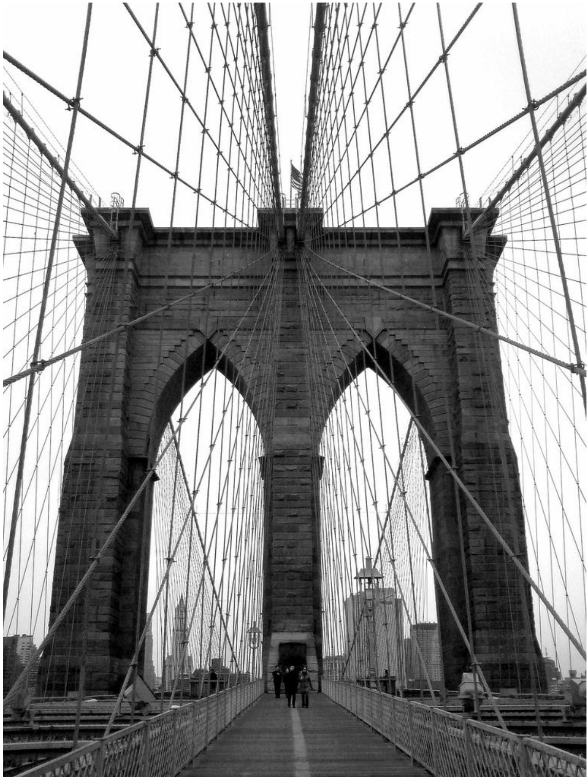
obr. 10 Brooklynský most. Systém zavěšení šikmých kabelů vycházejících paprskovitě z hlavy pylonů
