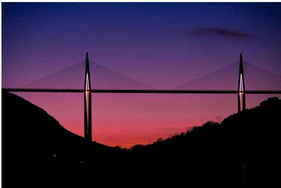
obr. 20 b) Viaduct de Millau
