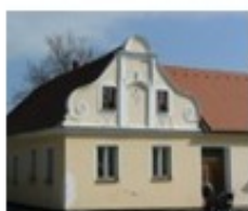
Obr. 2 Stavba Jakuba Bursy
