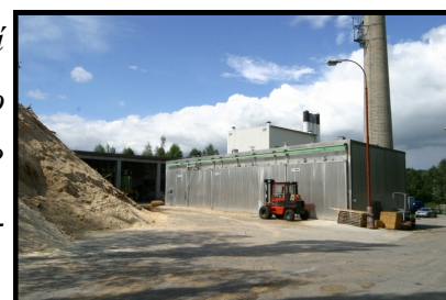
Obr. 50 Teplárna na biomasu
