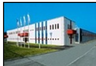
Obr. 22 Závod balené vody Dobrá Voda
