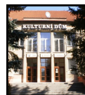
Foto. 4 Kulturní dům Trhové Sviny
