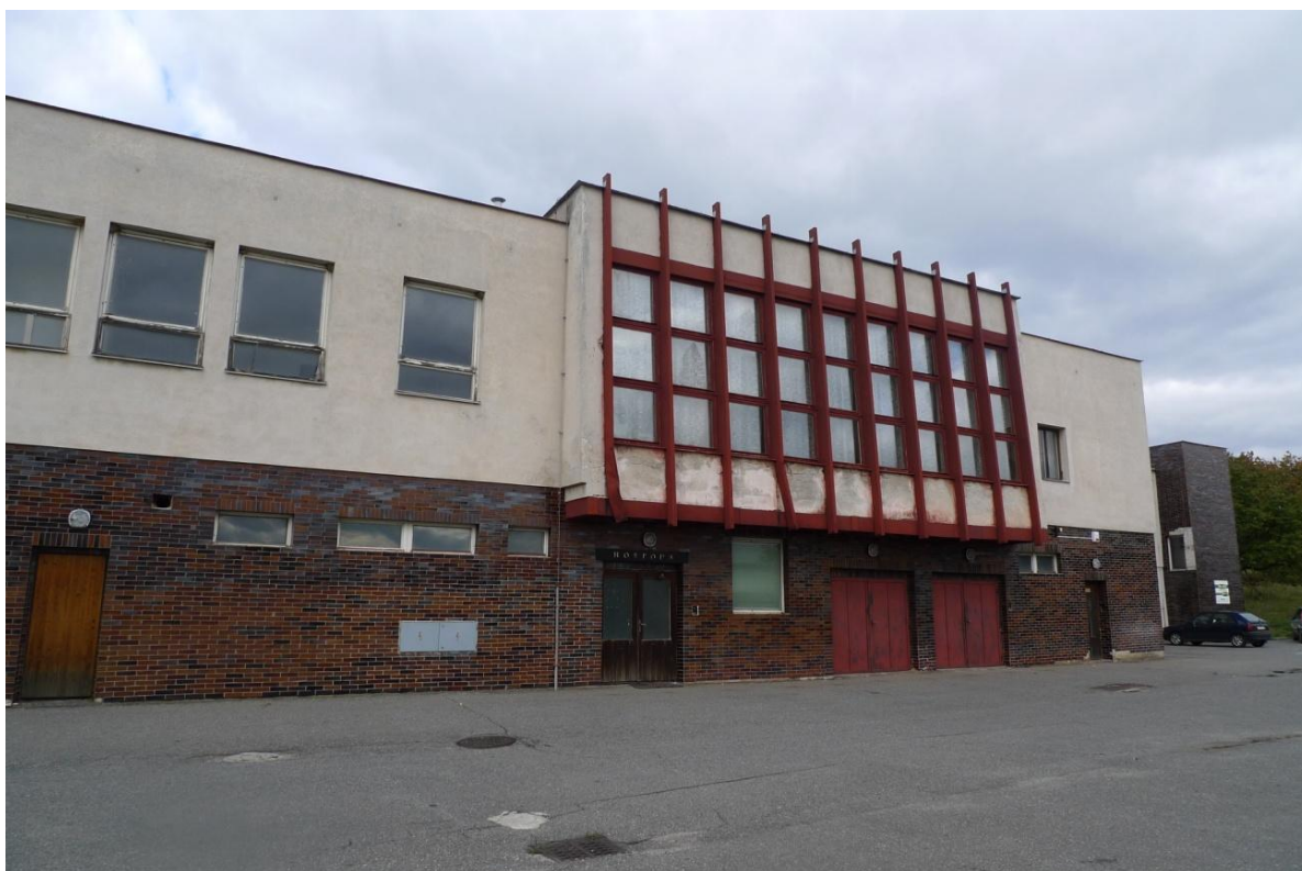
Foto 2. Administrativní budova ZD s bývalými ubytovacími prostory
