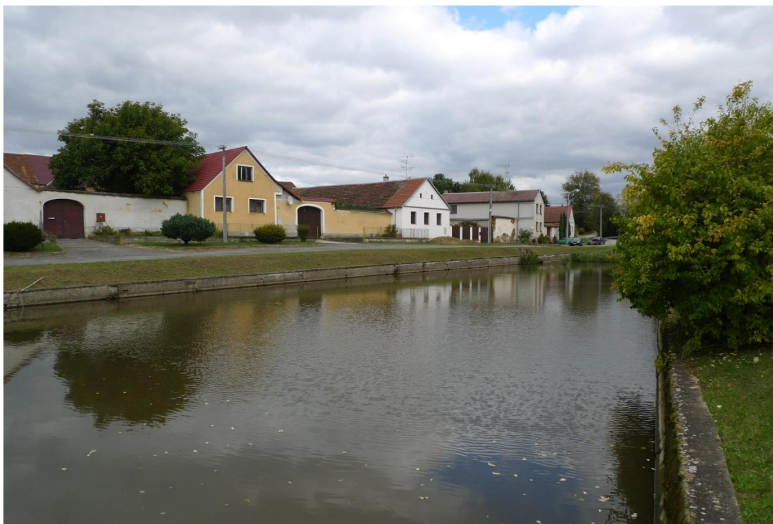
Foto 10. Požární nádrž v sídle Vnorovice
