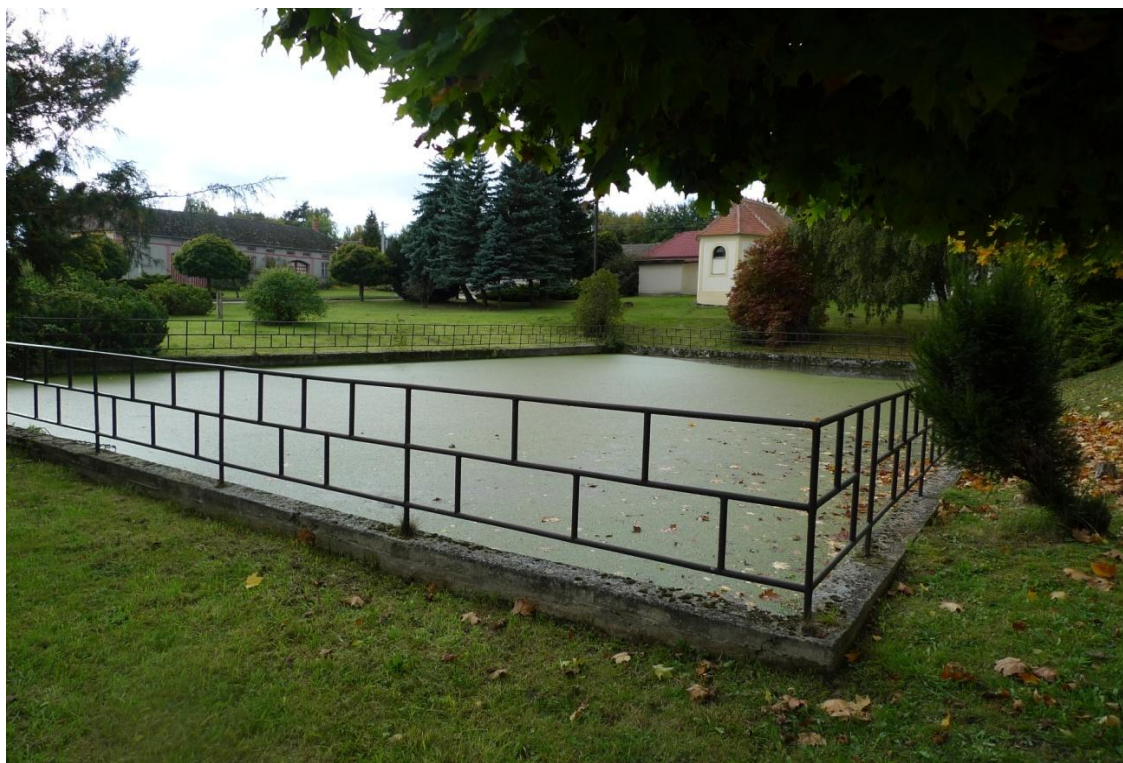
Foto 16. Požární nádrž na návsi v sídle Nové Dvory
