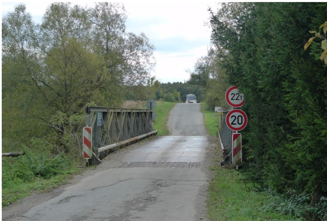
Foto 19. Provizorní most přes Janovský potok v sídle Janov
