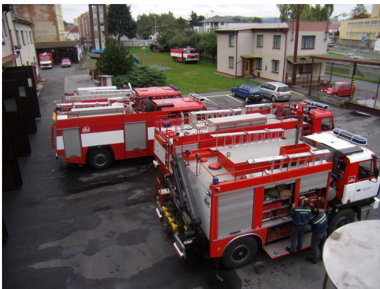
Obrázek č. 3 – Požární stanice Klatovy.
