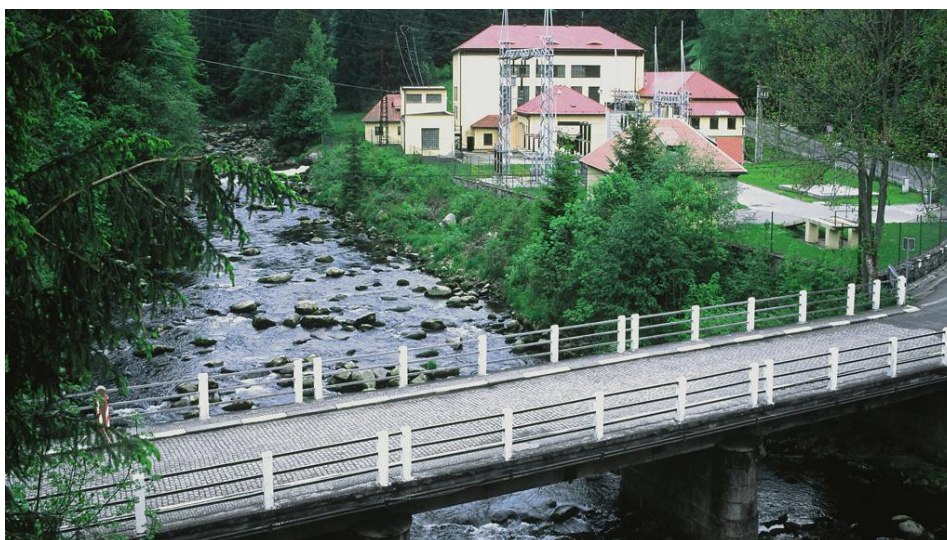
Obrázek č. 11 – vodní elektrárna Čeňkova Pila (dostupné na www.google.cz ).
