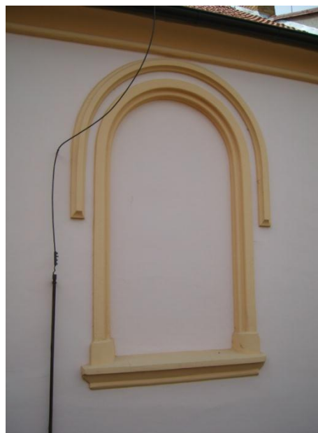
Slepé okno - severní strana budovy (zdroj: archiv autora)
