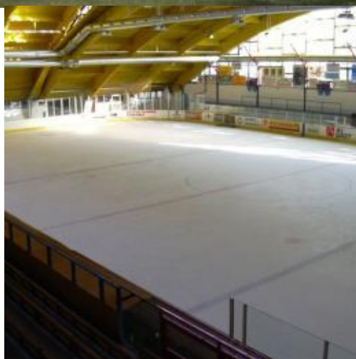
Příloha č. 43, 44 Zimní stadion ve Strakonících Na Křemelce – oblouková konstrukce tvoří jednu z městských dominant, vlevo pohled na ledovou plochu
