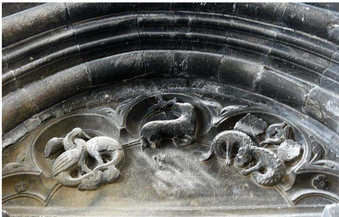
Portál z bývalé křížové chodby
