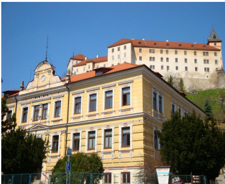
Obr. č. 13 – Budova Gymnázia Vimperk
