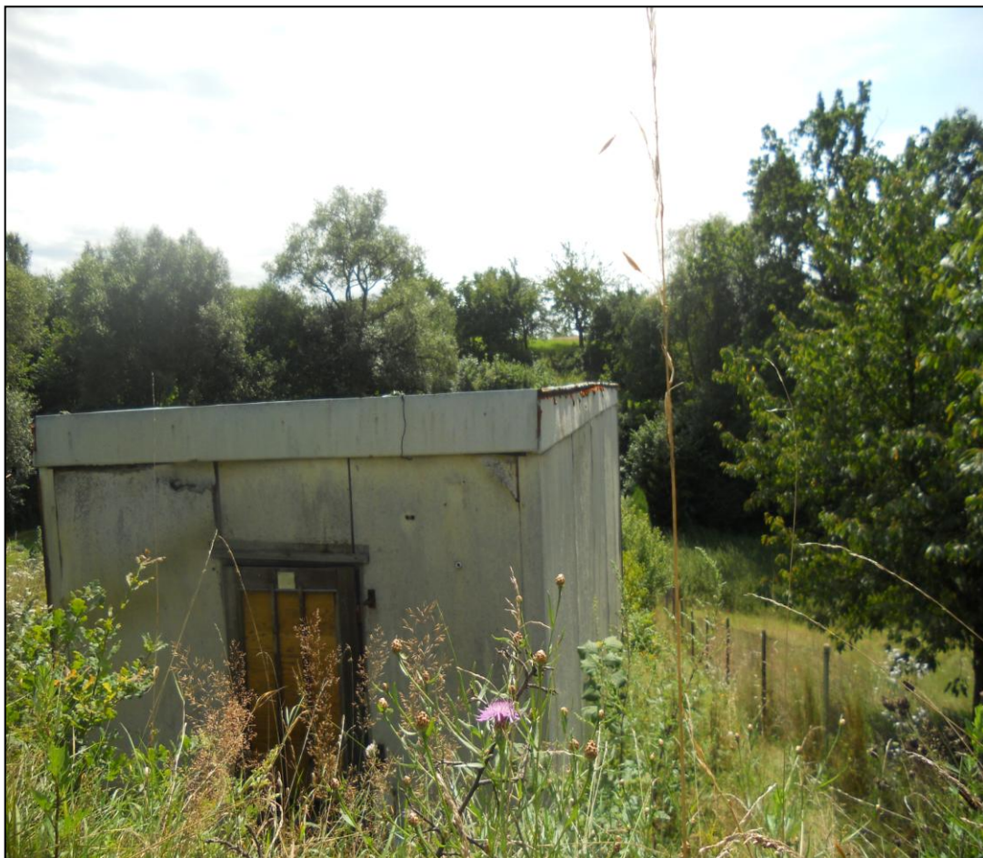
Obr. 18: Stavební buňka v chatové osadě JC10F4 Týn nad Vltavou – Račina. Chatáři stavební buňky původně využívali jako chaty.
