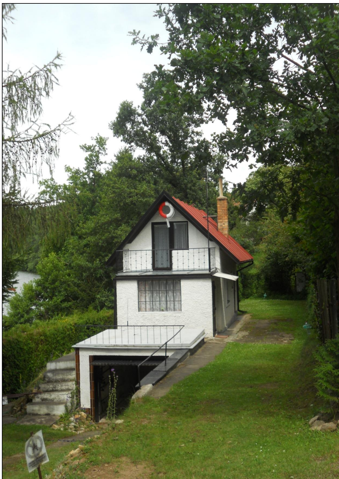
Obr. 21: Rekreační chata z r. 1945 v chatové osadě JC10E4 Týn nad Vltavou – Na Soutoku.
