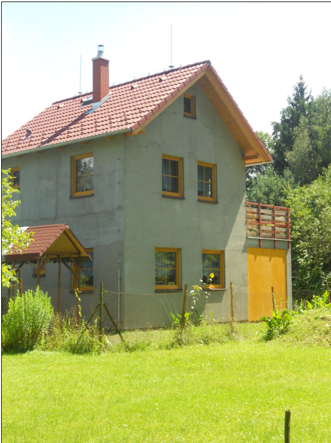
Obr. 6: Rekonstrukce chaty v chatové osadě JC10F6 Týn nad Vltavou – Bedrník.
