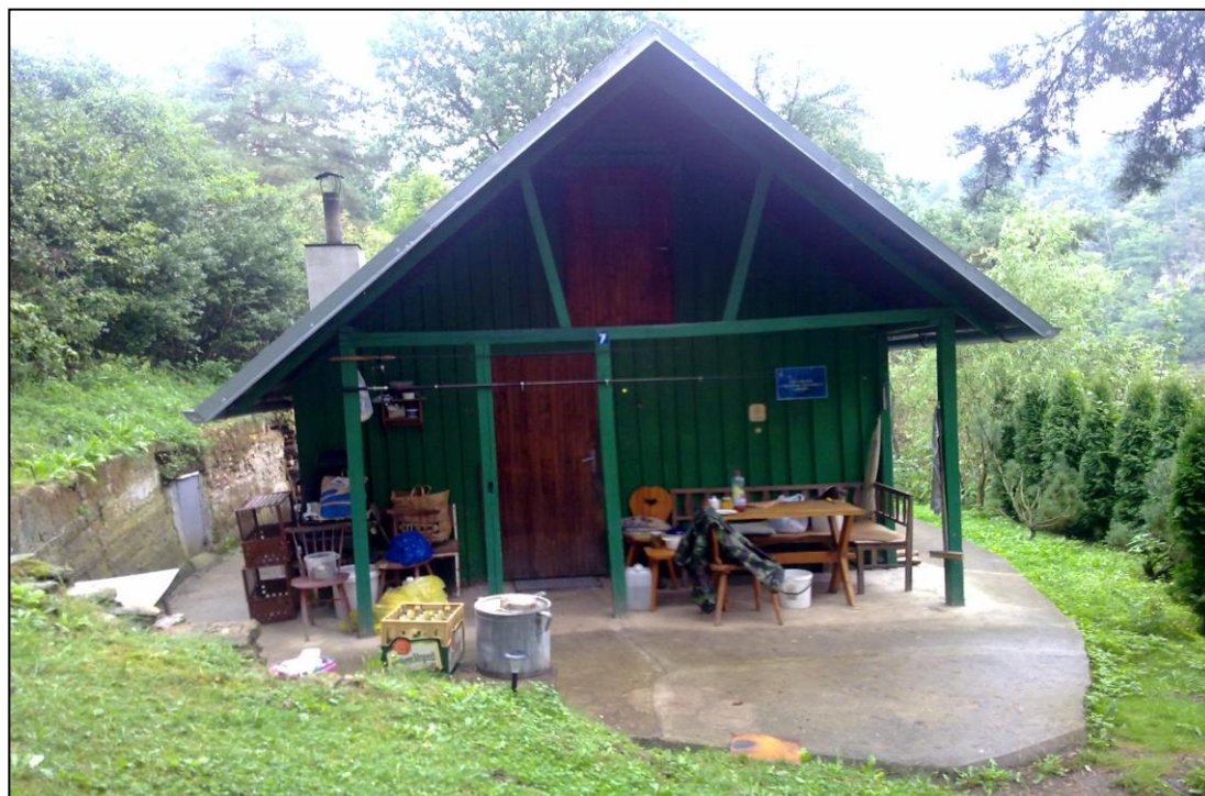
Obr. 4: Rekreační chata ze 70. let v chatové osadě JC10A2 Údraž - u rekreačního zařízení Rejzíkovi s.r.o. Jedná se o chatu obývanou rybáři, ti zde nechávají své věci volně přístupné i v případě, kdy jsou lovit ryby z pramice, protože chaty jsou špatně dostupné a málokdo ví, že se zde nacházejí.
