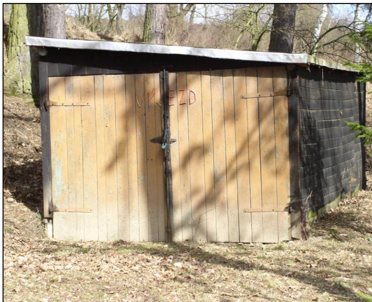
Obr. 11: Parkovací přístřešek v chatové osadě
