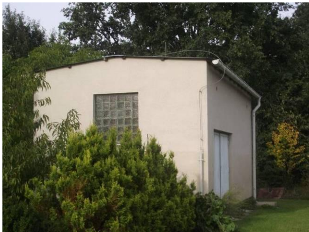
Foto 15: Centrální vodárna v zahrádkové osadě JC9I2 Veselí n. L. – jih – u Lužnice
