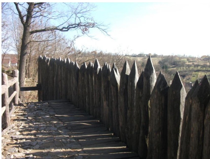
Takzvané „tužky“ – hroty kůlů palisády
