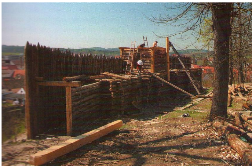
Budování hradby s obranou věží 67
